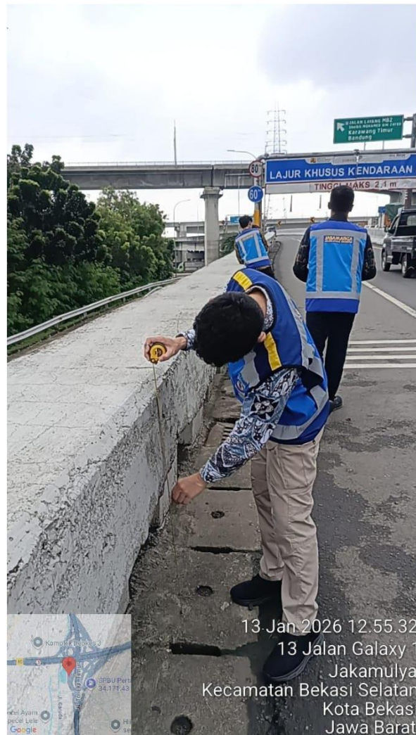
Gambar 17. Survei pengukuran eksisting Jalan Layang MBZ lanjutan.
