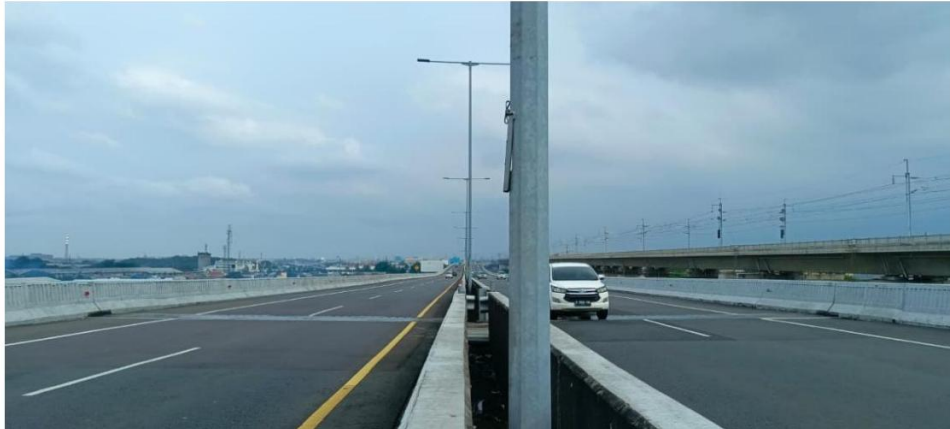
Gambar 14. Foto kondisi eksisting Jalur Jalan Layang MBZ arah Cikampek.
