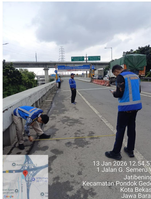
Gambar 16. Survei pengukuran eksisting Jalan Layang MBZ.
