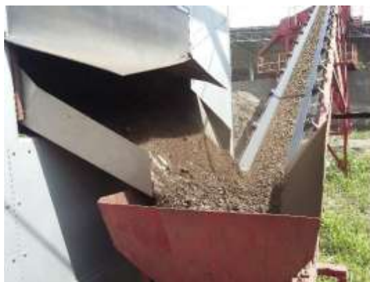
Gambar.2 Pemecahan material RAP
